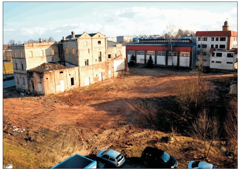
Tereny powstałe po wyburzeniu pustostanów przy ul. Batorego 4, 4a oraz 6
